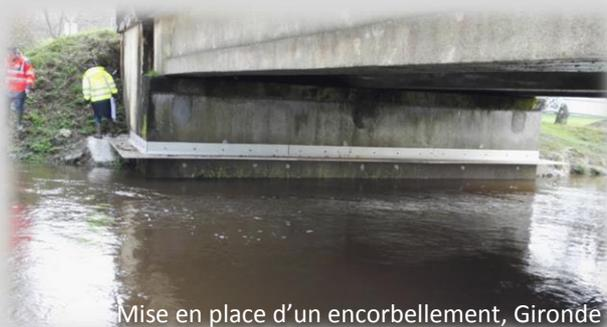
Mise en place d'un encorbellement, Gironde
