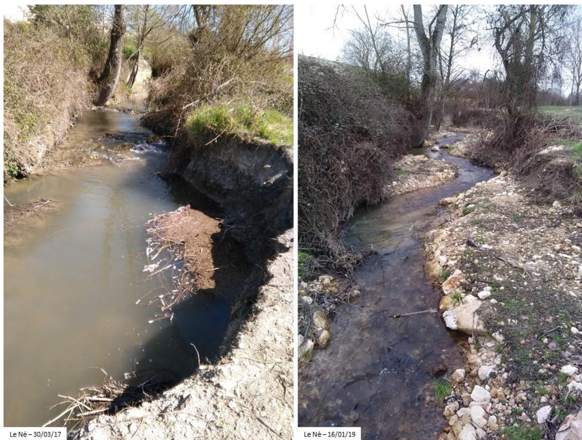
Figure 2 : travaux réalisés sur le tronçon du Né
