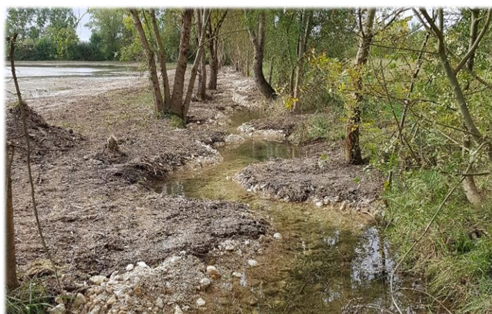
Figure 3 : restauration du cours d'eau bordant la frayère
