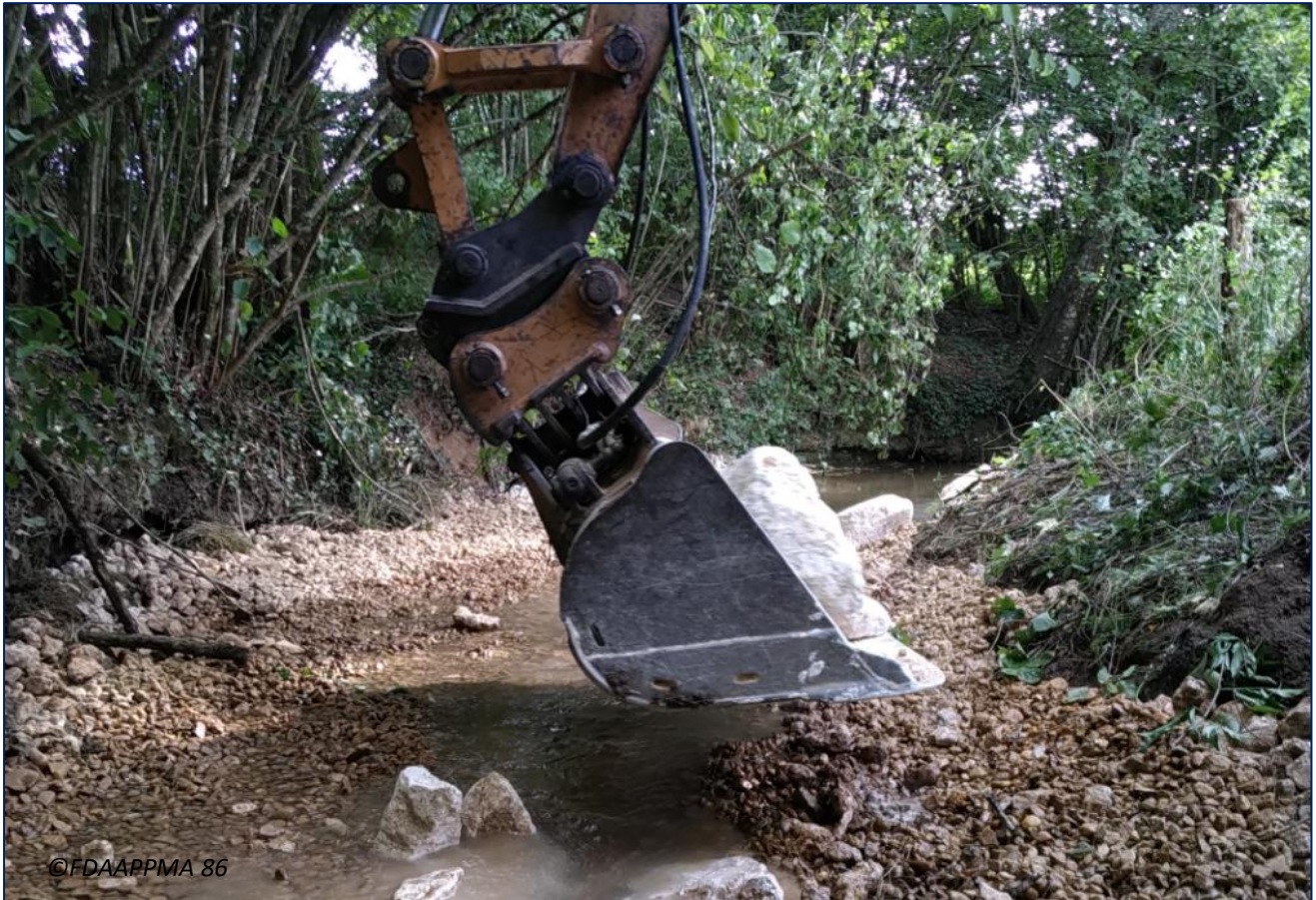
Figure 1 : Photographie de la restauration en cours sur la Rhune en 2018.
