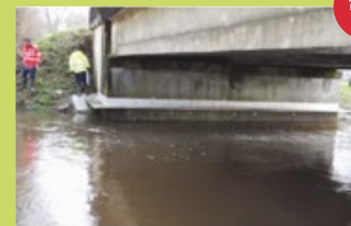
Mise en place d'un encorbellement, Gironde
