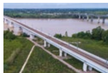
Construction d'un viaduc au-dessus de la Dordogne, Saint Loubès, Gironde
