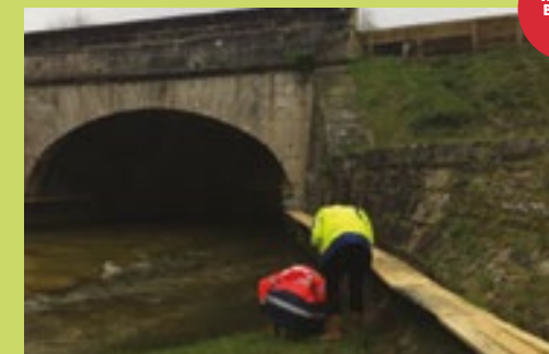
Mise en place d'une banquette, Gironde
