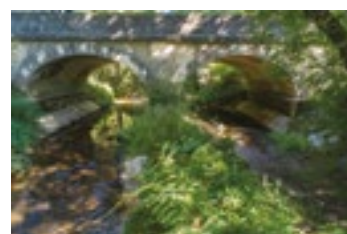
Installation de passerelles en faveur des mammifères semi-aquatiques (et notamment du vison) sous un ouvrage existant, Gironde
