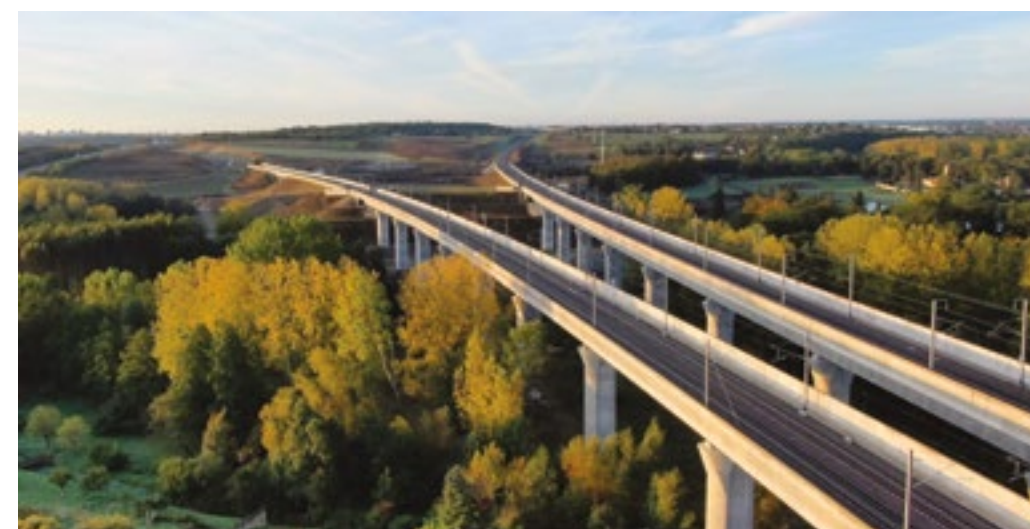
Viaducs de franchissement de l'Auxance, Chasseneuil-du-Poitou, Vienne
