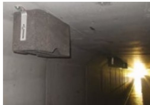
Exemple d'installation de gîte à chiroptères à Bécheresse, Charente
