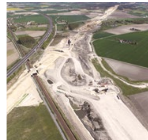
Terrassement tranchée de Veigné, Indre-et-Loire
