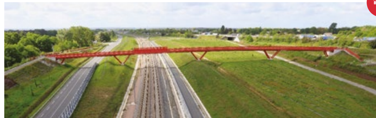
Passerelle piétonne à Aubie-et-Espessas, Gironde
