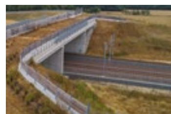
Ouvrage de transparence : passage grande faune à Vouharte, Charente
